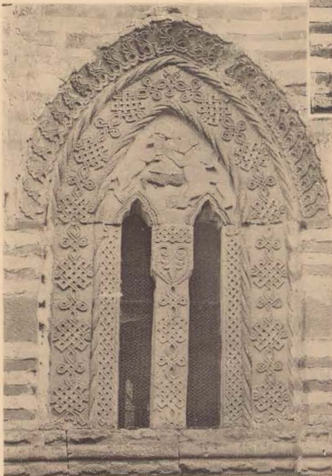
226. Kalenić. Fenêtre du bas-côté nord-ouest.
